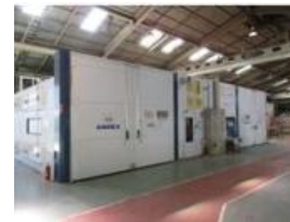
工場内作業環境測定
