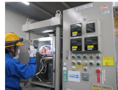
動力プレス劣化状態点検
